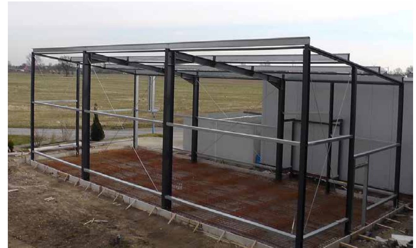
Rohbau der neuen Lagerhalle.
